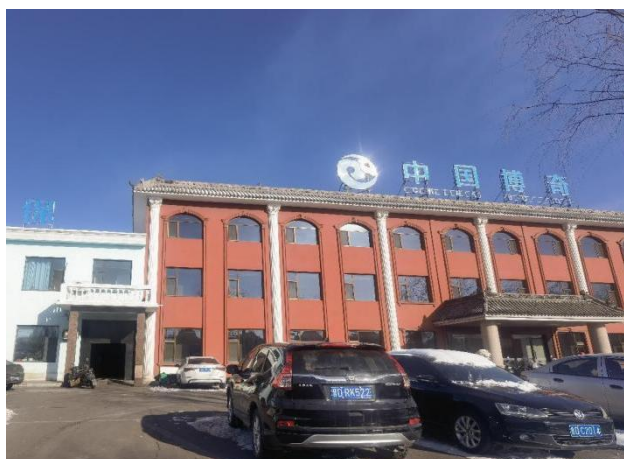
潞宝工业园区污水处理中心
