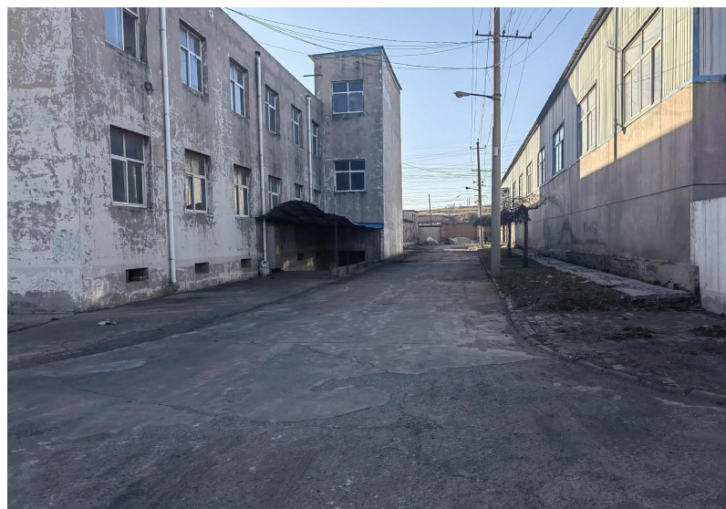
厂区内道路现状
